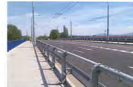
Obr. 5 Chodník a vozovka po rekonštrukcii mosta
