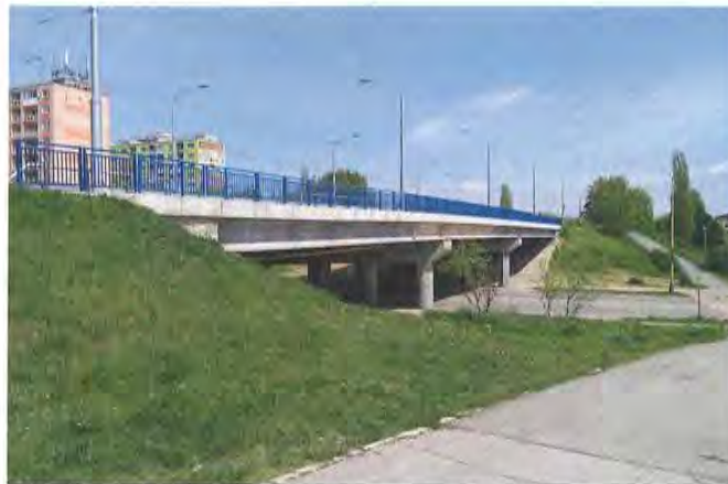
Obr. 9 Celkový pohľad na most pred ukončením rekonštrukčných prác
