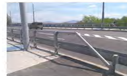
Obr. 6 Zábradlové zvodidlo pri prechodovej oblasti mosta
