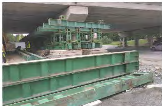
Obr. 3 Příprava na zdvihanie nosnej konštrukcie, podpera č. 3
