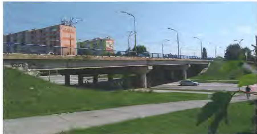
Obr. 1 Pohľad na most pred rekonštrukciou
